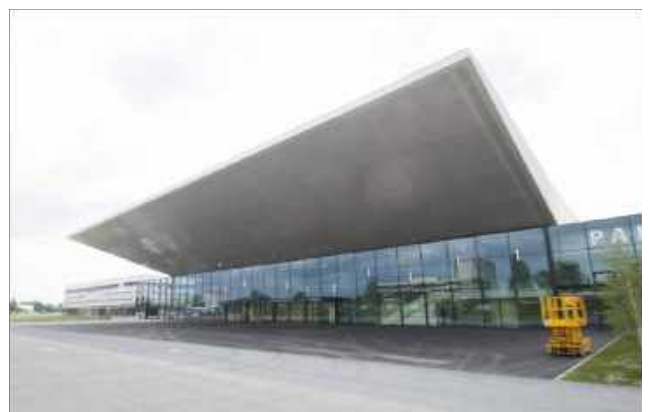
ETFE-Außenverkleidung in Bordeaux
