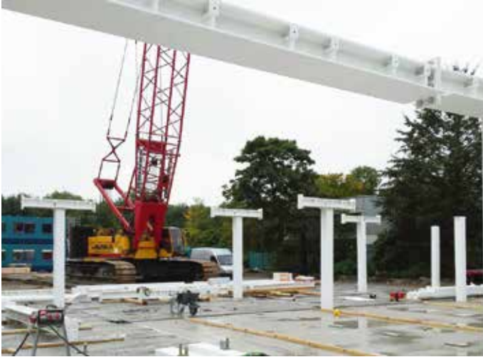
Momentvast T-stuk waartussen de liggerdelen worden gemonteerd.
