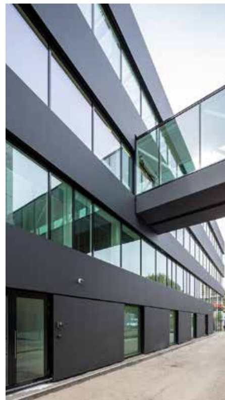
Loopbrug verbindt oudbouw met nieuwbouw.
