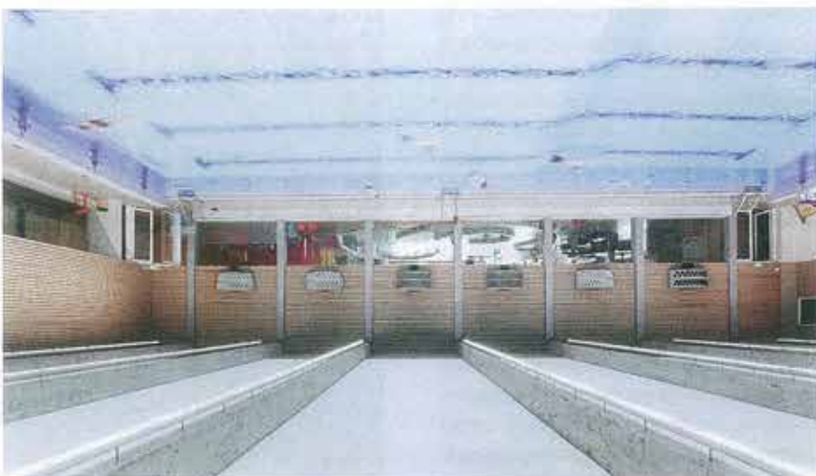
Het oude plafond kwam over als één grote massa, het maakte de ruimte kleiner en er waren problemen met het onderhoud.
