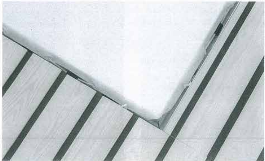
Door een speciaal ontwikkeld profiel, blijft het chloorbestendige spanstelsel uit zicht.
