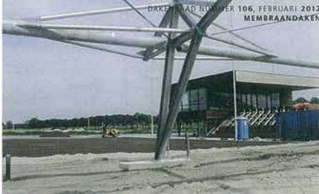
Elk spant heeft aan weerszijden een pootconstructie die is verankerd aan een onderheide betonpoer.
