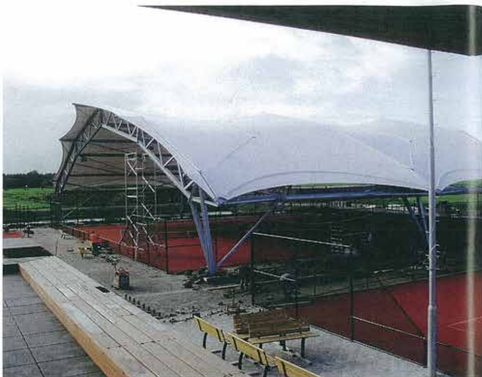
Beeld vanaf het verhoogde terras voor het clubgebouw. De diagonalen op het membraan zijn de dalkabels en de gebogen lijn aan de voorkant de regengeleiding.
