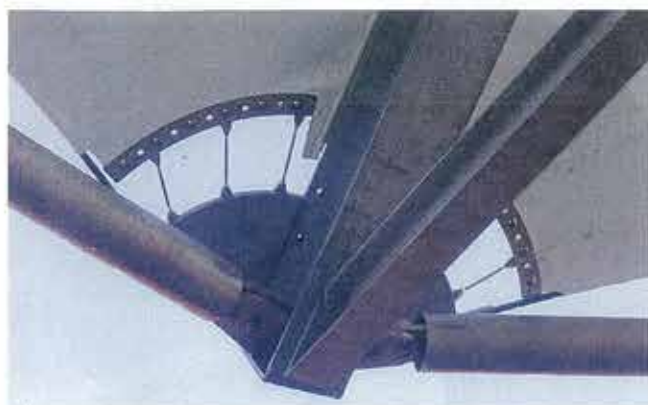
Een spanpunt van het membraan van onder- en van bovenaf gezien. Aan het membraan is een stalen strip bevestigd en vandaar lopen 'spanners' naar een stalen ankerplaat, die is gelast op de pootconstructie.
