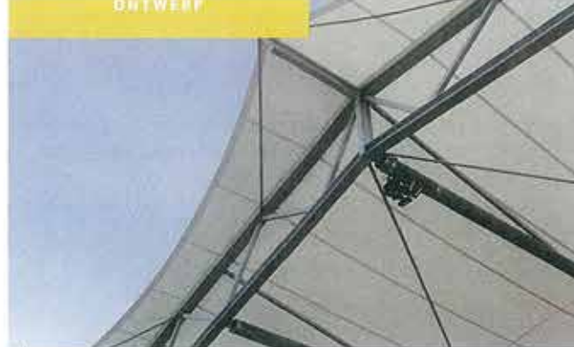
De luifels aan de lange zijden van de overkappingen zijn als aparte membranen uitgevoerd en worden ondersteund door korte stukken staalprofiel.
