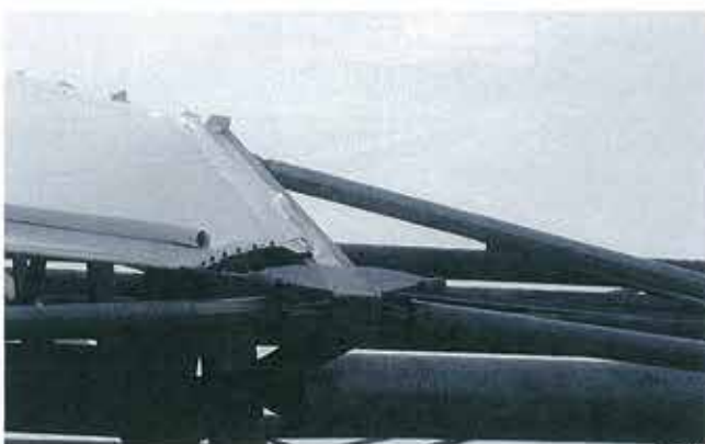
Een spanpunt van het membraan van onder- en van bovenaf gezien. Aan het membraan is een stalen strip bevestigd en vandaar lopen 'spanners' naar een stalen ankerplaat, die is gelast op de pootconstructie.
