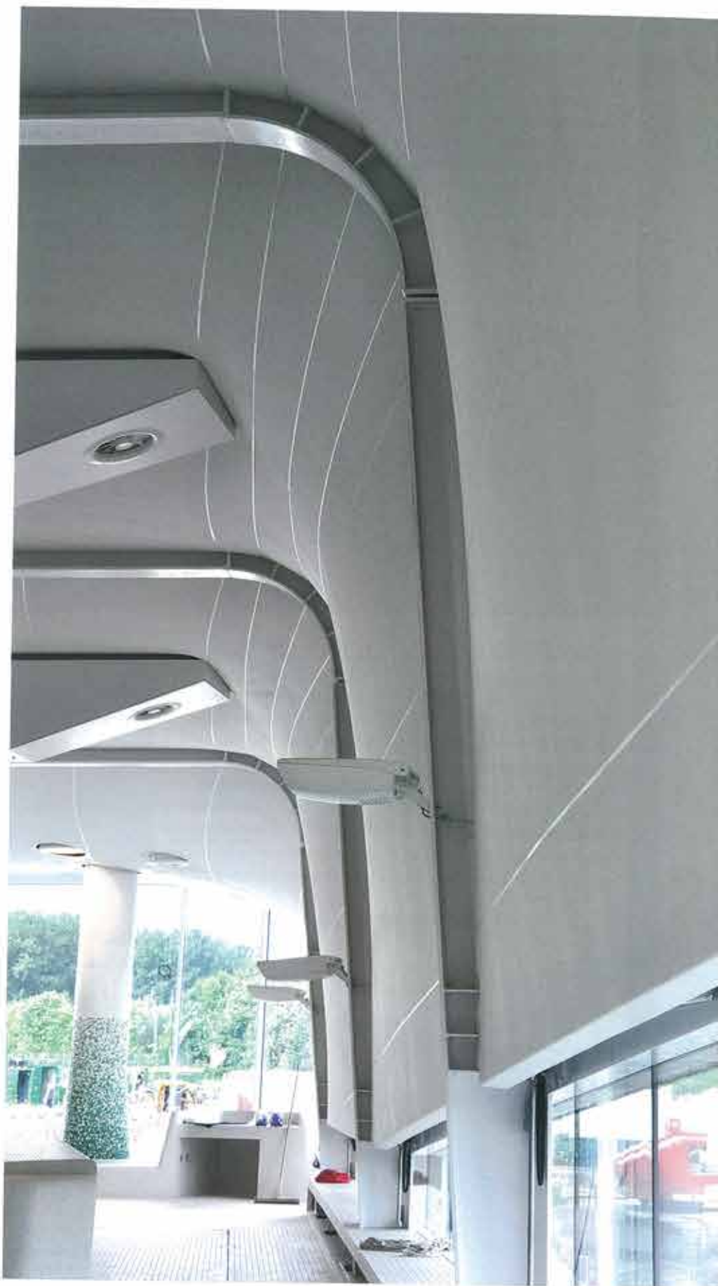
Het spanplafond van gecoat en geperforeerd polyesterdoek volgt de vorm van de spanten. Bij de aansluitingen op bouwkundige onderdelen is het doek zorgvuldig afgewerkt met tape.
