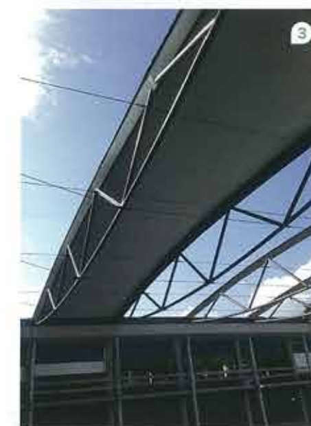
1 // In de zomer worden de opgevouwen kussens in een berging op het dak gelegd. 2 // Spankabels rondom houden de isolatieflappen strak over de naden. 3 // De spanten zijn onderling verbonden, met name om de krachten op te vangen bij de (de)montage van het dak. 4 // Er is door de samenwerkende partijen veel aandacht besteed aan de bouwkundige detaillering van goten en randaansluitingen. 5 // In materiaalgebruik heeft Jeanne Dekkers Architectuur met natuurlijke robuuste materialen aansluiting gezocht bij de groene omgeving. 6 // De motoren voor het luchtkussendak staan op het dak opgesteld.
