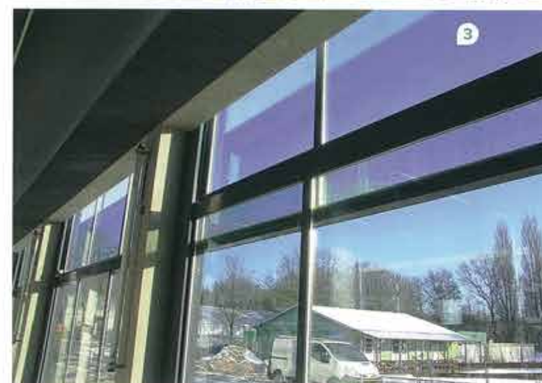
1 // De architectuur van het bad is afgeleid van een Romeins zuilenbad. De galerij kan ook als tribune worden gebruikt. 2 // De gevel is in drie horizontale delen opgedeeld, waarvan het onderste deel te openen is. 3 // De bovendorpel van de hefpuil werkt in gesloten toestand samen met de onderdorpel van de bovengelegen pui.
