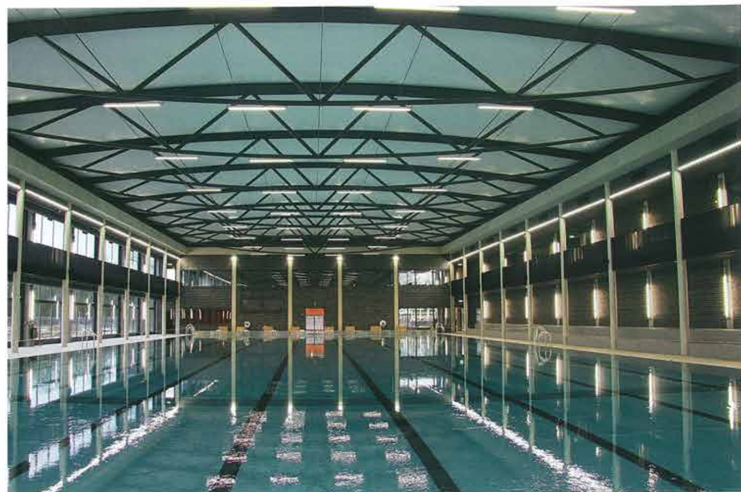
Het luchtkussendak is bewust niet translucient gemaakt. Dit voorkomt verblindende schitteringen in het water.
