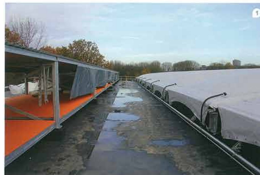
1 // In de zomer worden de opgevouwen kussens in een berging op het dak gelegd. 2 // Spankabels rondom houden de isolatieflappen strak over de naden. 3 // De spanten zijn onderling verbonden, met name om de krachten op te vangen bij de (de)montage van het dak. 4 // Er is door de samenwerkende partijen veel aandacht besteed aan de bouwkundige detaillering van goten en randaansluitingen. 5 // In materiaalgebruik heeft Jeanne Dekkers Architectuur met natuurlijke robuuste materialen aansluiting gezocht bij de groene omgeving. 6 // De motoren voor het luchtkussendak staan op het dak opgesteld.
