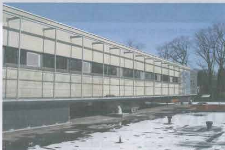
Exterieur van de nieuwbouw in Den Dolder. Het doek is hier toegepast als permanente gevelbekleding. Foto's: Buitink Technology
