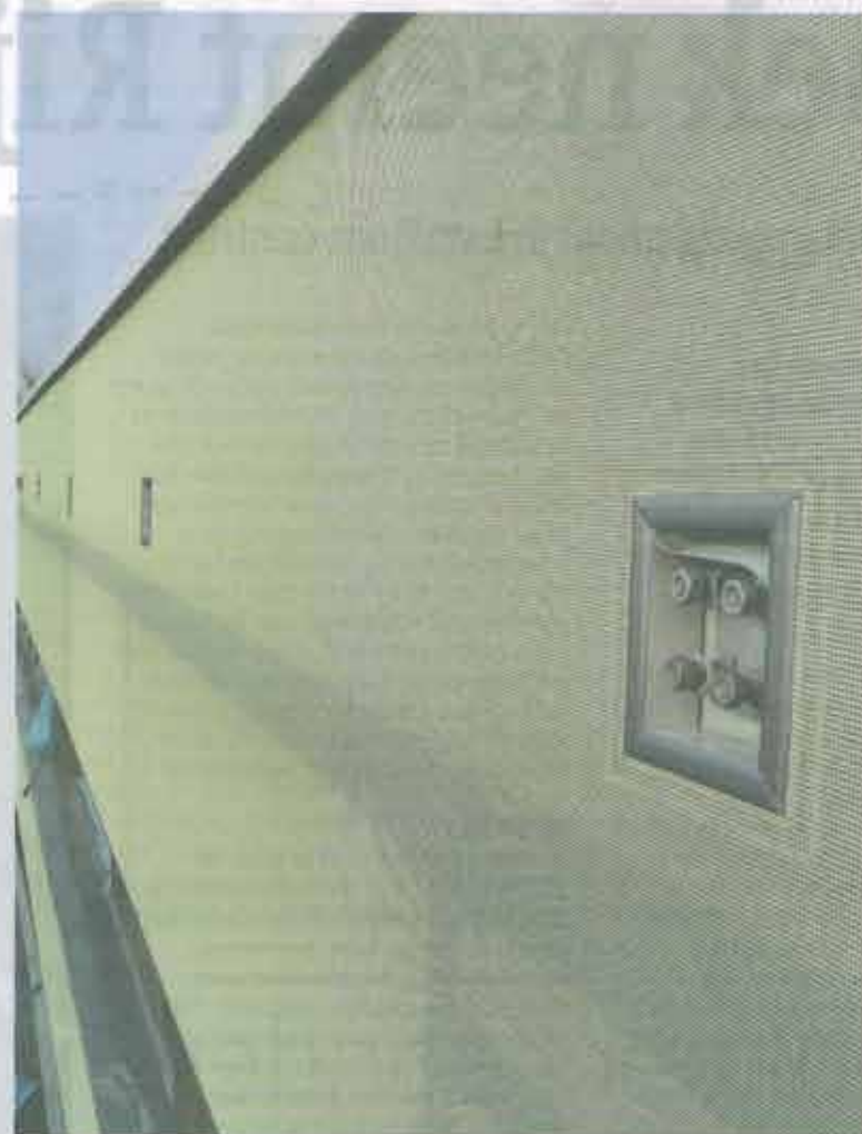
Alle doorvoeren en aansluitingen zijn in het gevelsysteem geïntegreerd.
