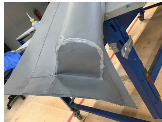
Dicht gelaste kopse kant; tegen wand of aansluitend element volledig afkitten
